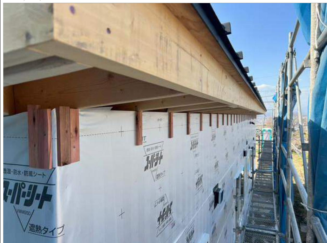
3-4□軒天井と外壁の取り合い部の防水紙張り上げは目安として、軒天井から100mm程度以上、又は小屋裏換気に支障がないところ（垂木下端など）まで張り上げる。(2/2)
