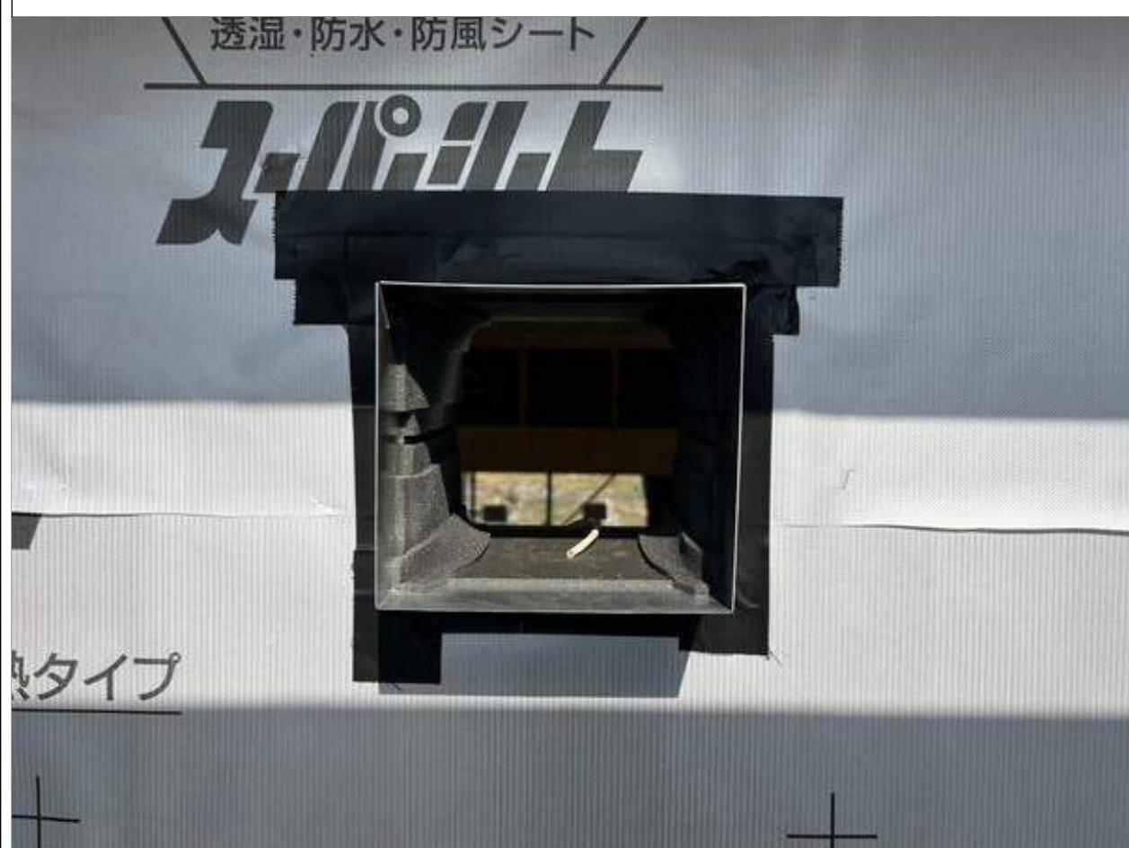
3-4□軒天井と外壁の取り合い部の防水紙張り上げは目安として、軒天井から100mm程度以上、又は小屋裏換気に支障がないところ（垂木下端など）まで張り上げる。(1/2)
