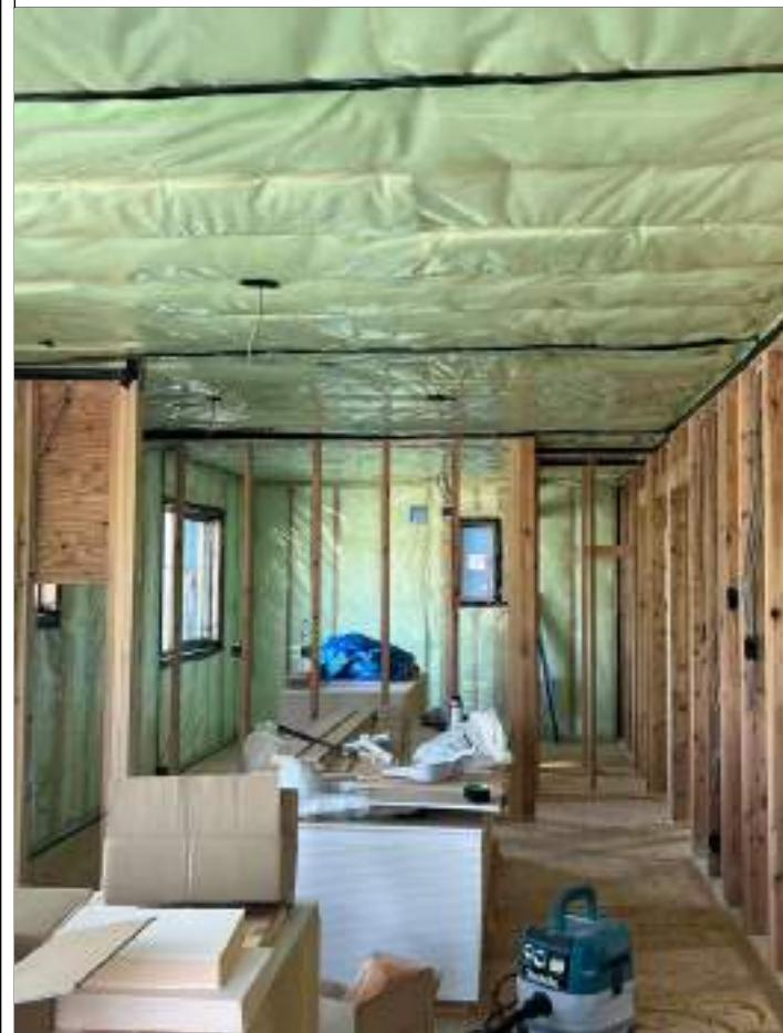
2-3□断熱材は隙間・欠損・施工不良がないように施工する。 断熱材は配管部分
