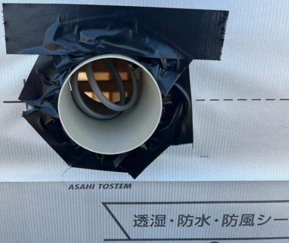
3-11 配管、配線が2本以上貫通する場合は、さや管を使用し、防水措置を適切
