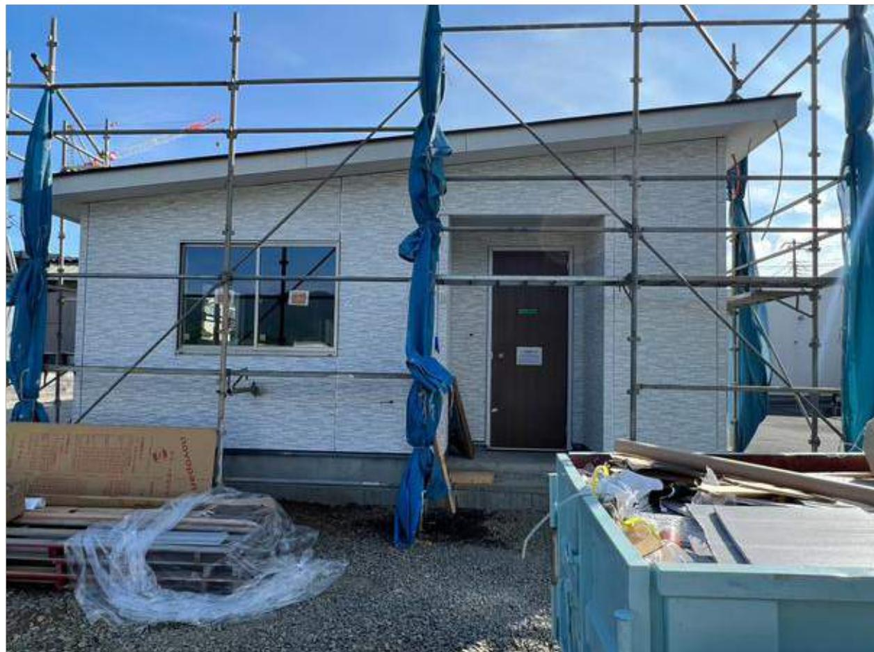
3-15 窯業系サイディング張りの取り付けは、目地通り良く、不陸、目違い等のないように行う。サイディングと土台水切り等の取り合いは、10mm程度の隙間をあける。(2/2)
